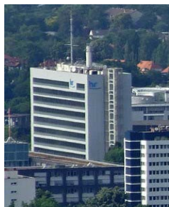
H R - Gebäude
